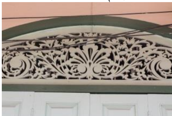
ภาพ ช่องระบายลมประตูอาคารเรียนซีไทล์กี (ถ่ายโดย ชลาพันธ์ อูปกิจ)
